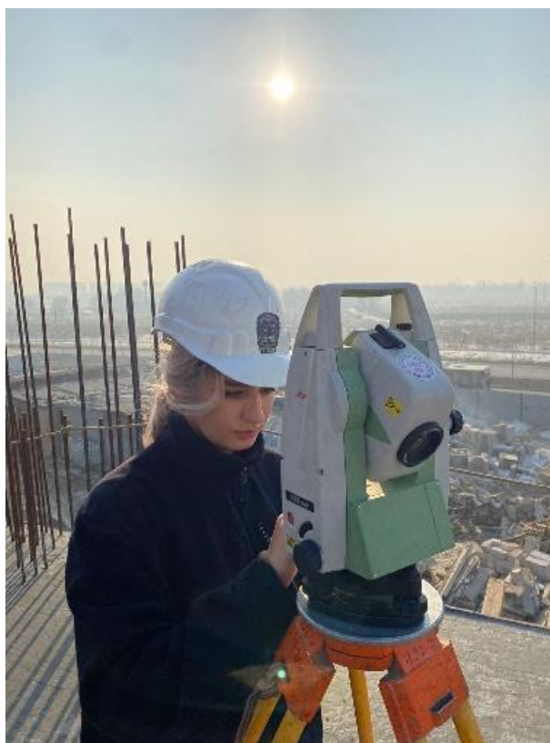
Рисунок 11- Выполнение разбивки осей
